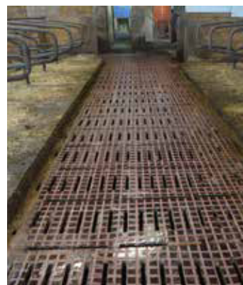
Rillen in Laufgang schneiden, bietet wieder Rutschsicherheit.
