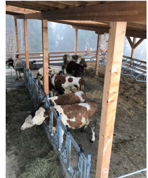
Außenklimastall mit darunter liegendem Mistlager
