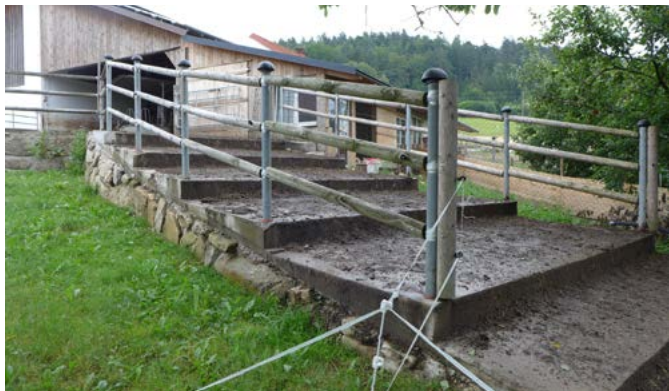
Schrittfreundliche Treppen als Zugang zu Weide
