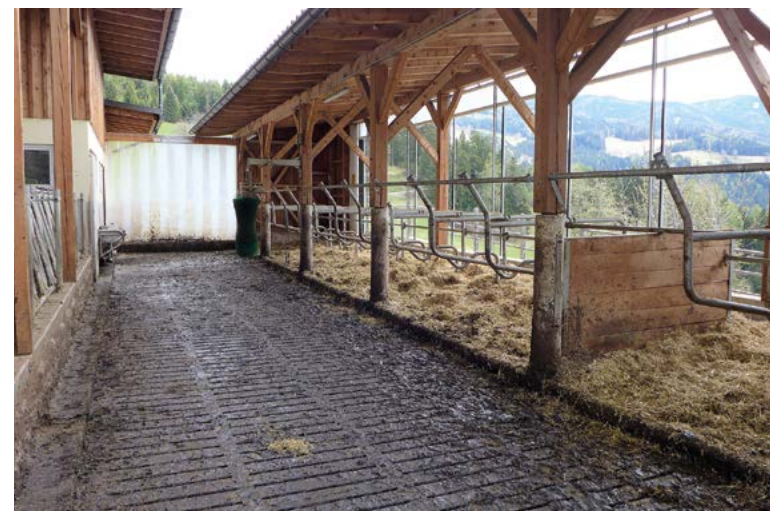
Laufgang mit darunter liegender Güllegrube
