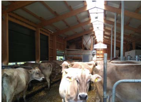
Firstentlüftung im Hallenstall
