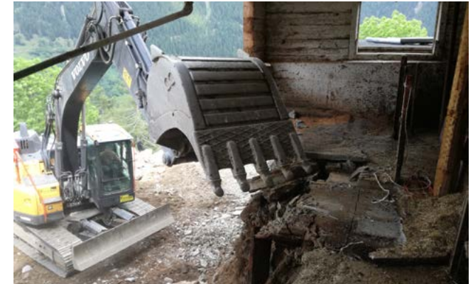
Abbrucharbeiten können sehr „tiefgreifend“ werden.
