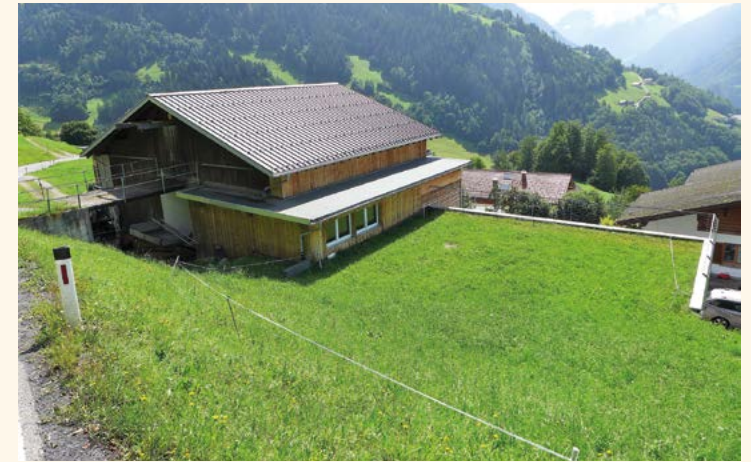
Begrüntes Dach auf dem Stallzubau
