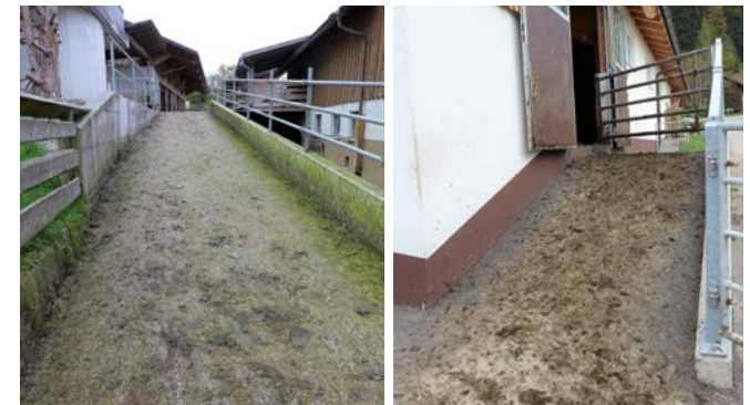
Links: Lange, flache Rampe zwischen Laufstall und altem Anbindestall als Melkstand; rechts: Rampe als Zugang zur Weide, leicht eingestreut gegen Rutschen
