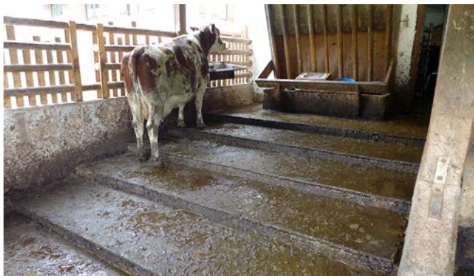
Treppen mit Gummiauflage zwischen Liege- und Fressbereich im Milchviehstall für 12 Kühe
