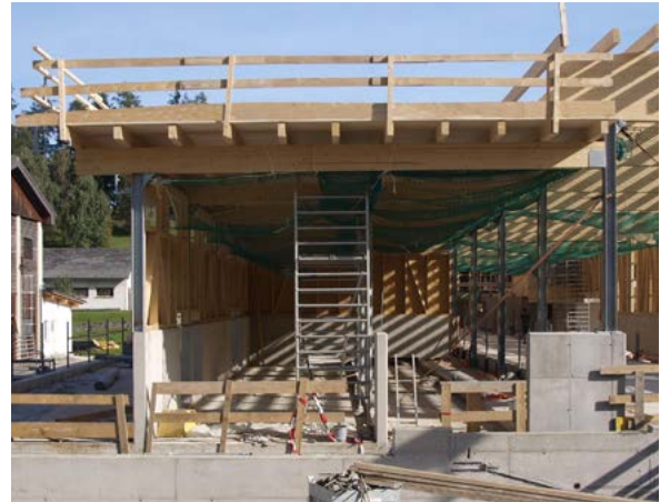
Geländer mit Fußwehr bis 20° Dachneigung (HBLFA Raumberg-Gumpenstein)
