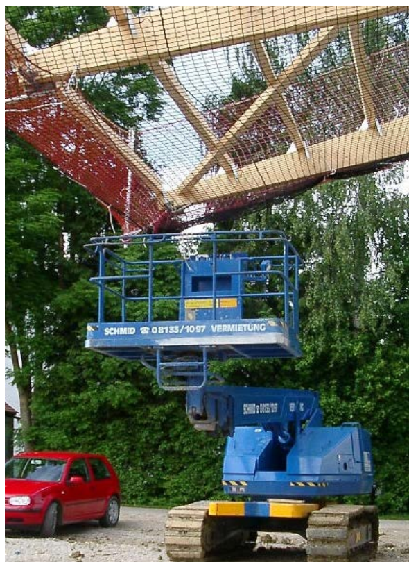
Hubarbeitsbühnen, Anseilen auch im Arbeitskorb (LSV FOB)
