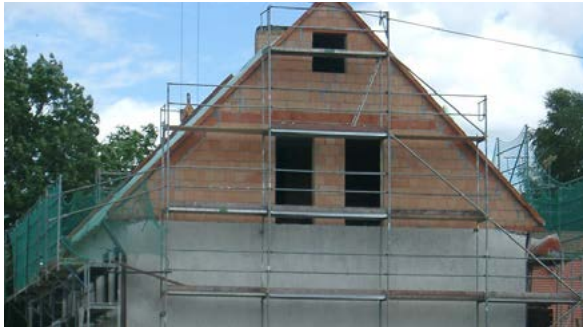
Arbeitsgerüst (LSV FOB)
