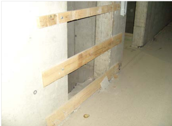
Gesicherte Wandöffnung (AUVA)
