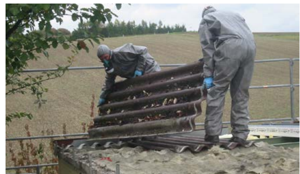
Schutz bei Arbeiten mit Asbestmaterial (oben: SVS, unten: Holzbau-Peter)
