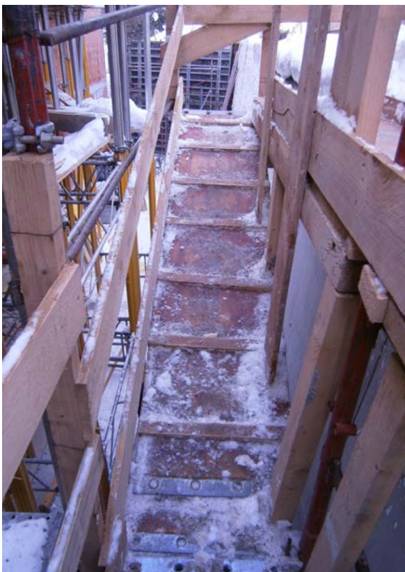
Rutschfeste Rampe (AUVA)
