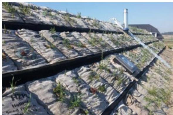
Abgetragener Oberboden wird für die Dachbegrünung verwendet; Sicherung gegen Abrutschen der Begrünung beim Steildach.
