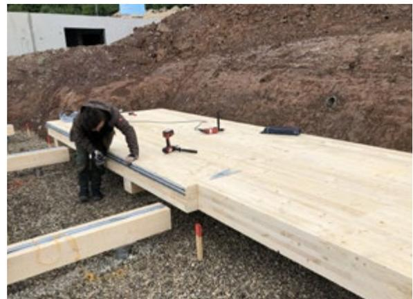
Anbringen einer Dichtbahn an ein Bodenplatten-element
