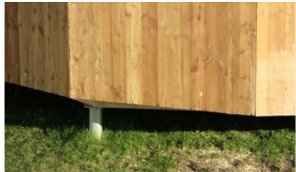
CLT-Bauwerk auf Schraubfundamenten – der Boden bleibt unversehrt.
