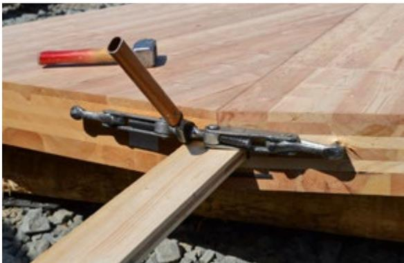
Balkenzug zum Zusammenziehen der CLT-Elemente
