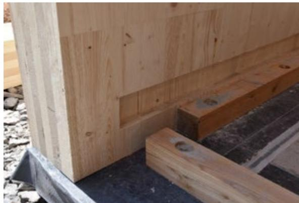
Für Installationen können auch werkseitig Nuten eingefräst werden (wie hier im Bereich des Anschlusses des CLT-Elements an die Betonplatte mit Bodenschwellen).
