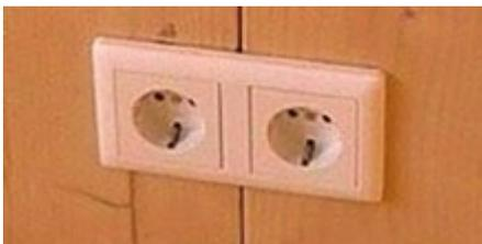
Werden Steckdosen direkt an der Nut angebracht, ist die Führung der Elektroinstallationen besonders einfach.
