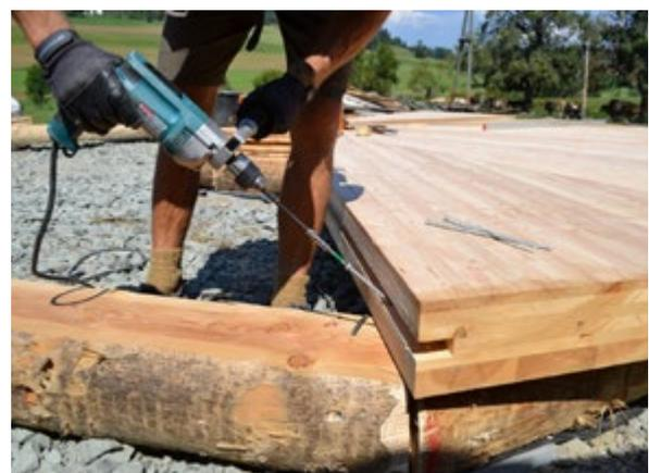
Befestigung eines Bodenelements mit Vollgewindeschrauben
