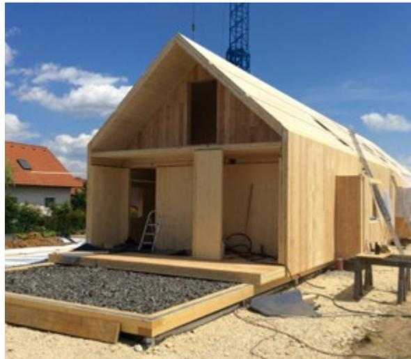
Einfamilienhaus auf Schraubfundamenten mit CLT-Bodenplatte auf Glasschaumschotter-Dämmung
