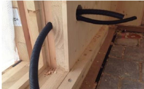
Elektroinstallationen können auch in Tür- oder Fensterausschnitten geführt werden. Diese werden durch die Laibung abgedeckt.
