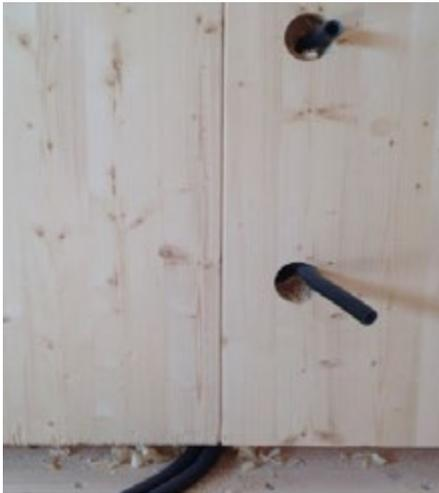
Führung von Elektroinstallationsschläuchen in der Nut
