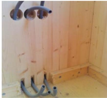
Werden Elektroinstallationen nicht in der Nut geführt, sind lange Spiralbohrer notwendig. Das Element wird stirnseitig vom Boden bis zum Auslass gebohrt.
