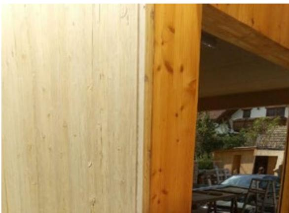
Zum Vergleich: links Imprägnierung auf Siliziumbasis, rechts Leinölanstrich
