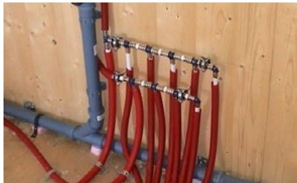
Wasser- oder Heizungsinstallationen können einfach ohne Dübel an den CLT-Elementen befestigt werden.
