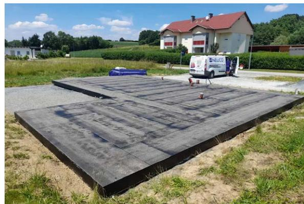
Fertigteile-Betonplatte (Neuco GmbH)
