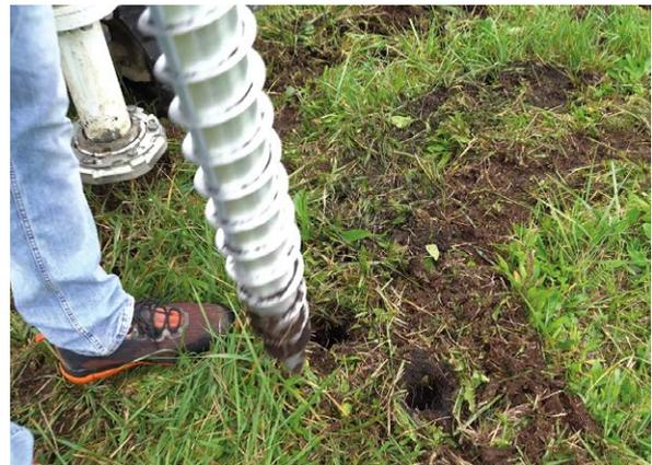
Rückbau eines Schraubfundaments ohne Flurschaden (ÖKL)
