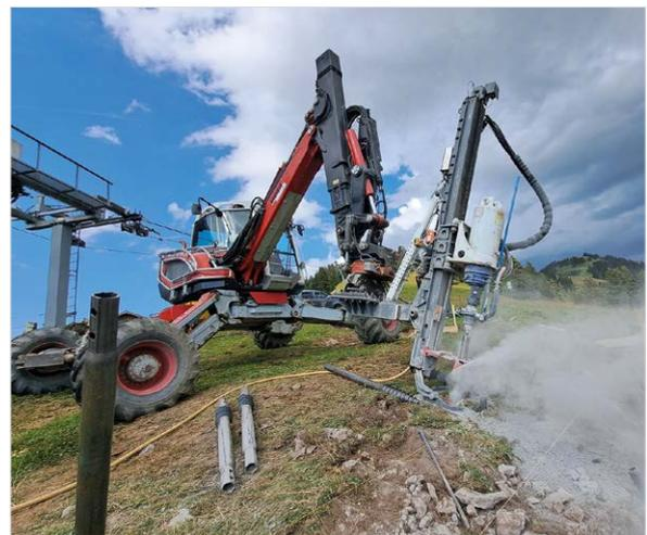
Einbau von Schraubfundamenten im steilen Gelände
