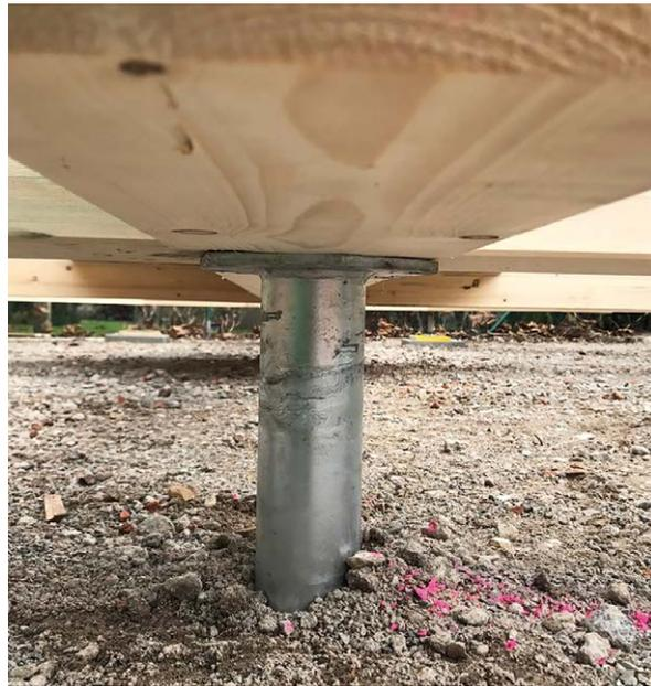
Schraubfundament mit Holzkonstruktion (Rast & Ruh GmbH)
