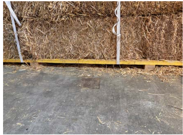
Sockelaufgabe bestehend aus Schalttafel und liegend eingebaute Staffeln (Hohensinner)
