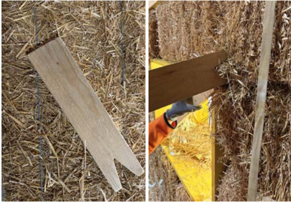
links: Strohstopfer, rechts: Ausstopfen von Hohlräumen mit Hilfe des Strohstopfers (Hohensinner)
