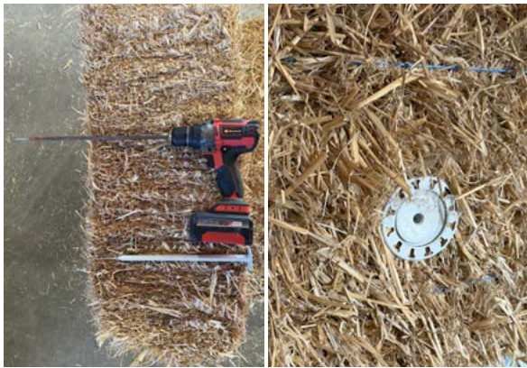
links: Tellerdübel mit Schraube und Akkuschauber mit speziell angefertigtem Bit (ca. 40 cm lang) für die Montage der Dübel, rechts: Strohballen mit Dübel an Wand (Holz, Ziegel oder Beton) befestigt (Hohensinner)
