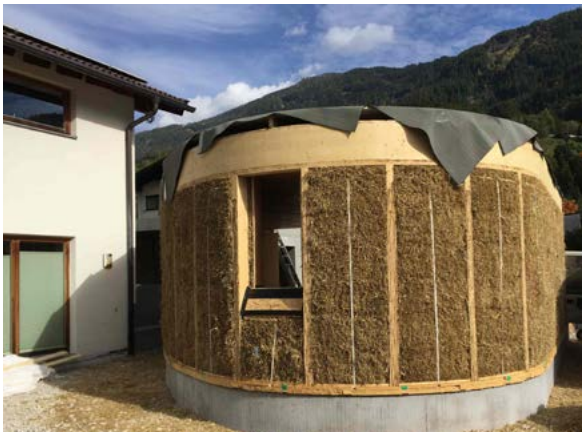
Holzständerkonstruktion (alle Kade)
