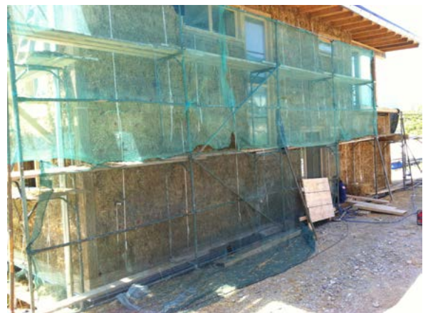
Strohballenfassade, auf Holz gedübelt
