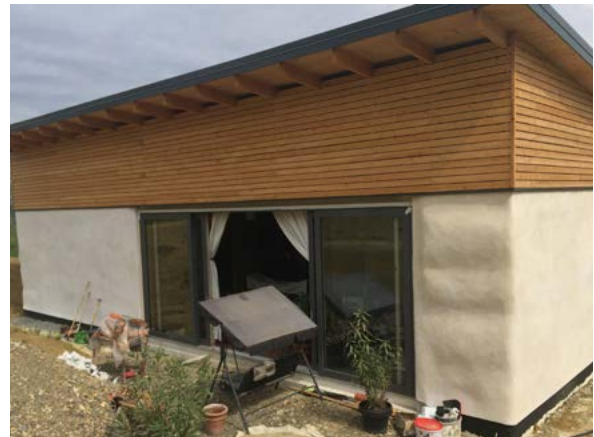
Lasttragende Bauweise mit Kleinballen (Kade)
