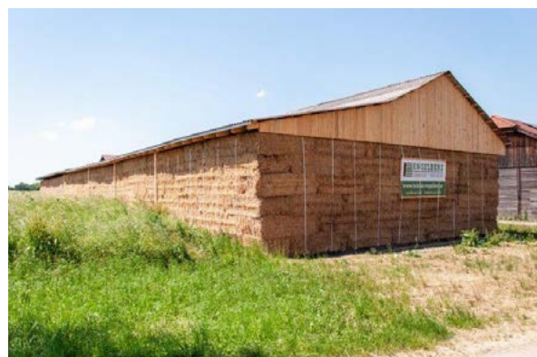
Lasttragende Bauweise für einen Einstellraum (beide Sonnenklee GmbH)
