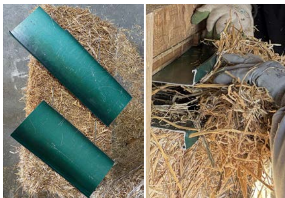
links: Rutschbleche, rechts: Austopfen von Hohlräumen mit losem Stroh mit Hilfe der Rutschbleche
