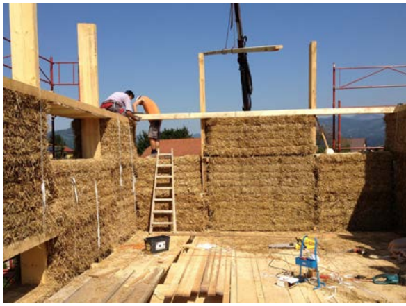
Teillasttragende Bauweise mit Großballen (Kade)
