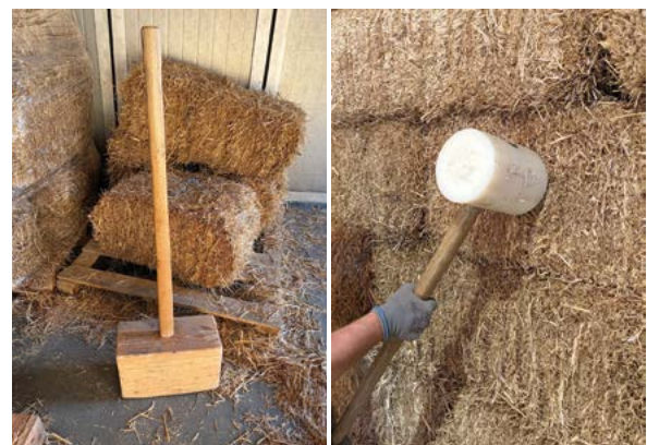
links: Strohhammer, rechts: Ausrichten der Ballen in der Wand mit Hilfe des Strohhammers (alle Hohensinner)
