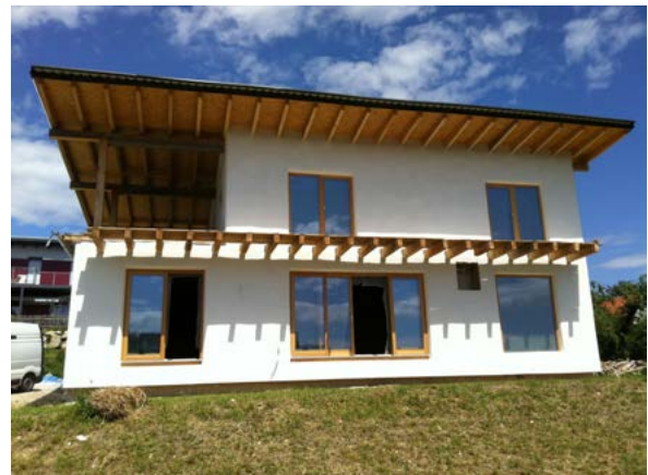
Strohballenfassade, auf Holz gedübelt (alle Kade)
