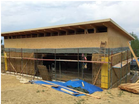
Teillasttragende Bauweise mit Großballen (Kade)
