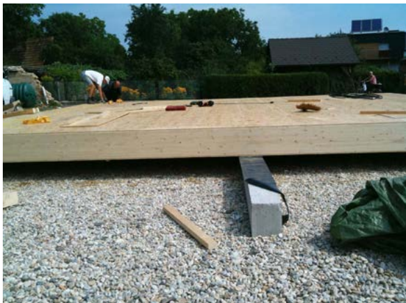
Bodenplatte mit Stroh (beide Kade)
