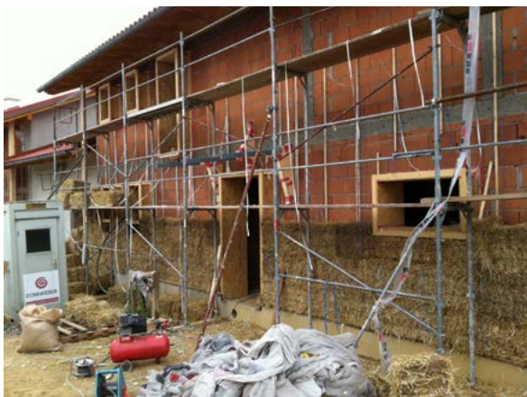
Ziegelneubau mit Wrapping einer Strohballendämmung
