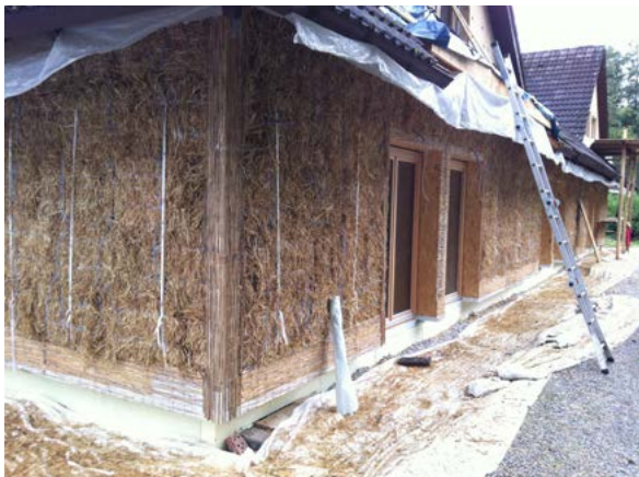
Strohballenfassade, auf einen Ziegelaltbau gedübelt
