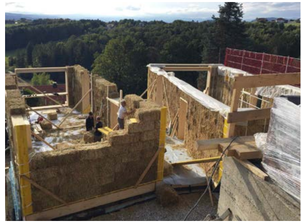
Lasttragende Bauweise mit Kleinballen (Kade)
