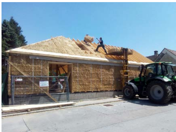
Lasttragende Bauweise mit Großballen (alle Kade)
